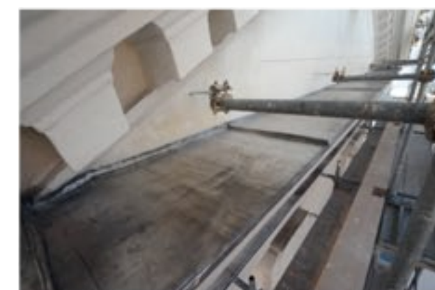
cornicione a restauro ultimato con copertina in piombo
