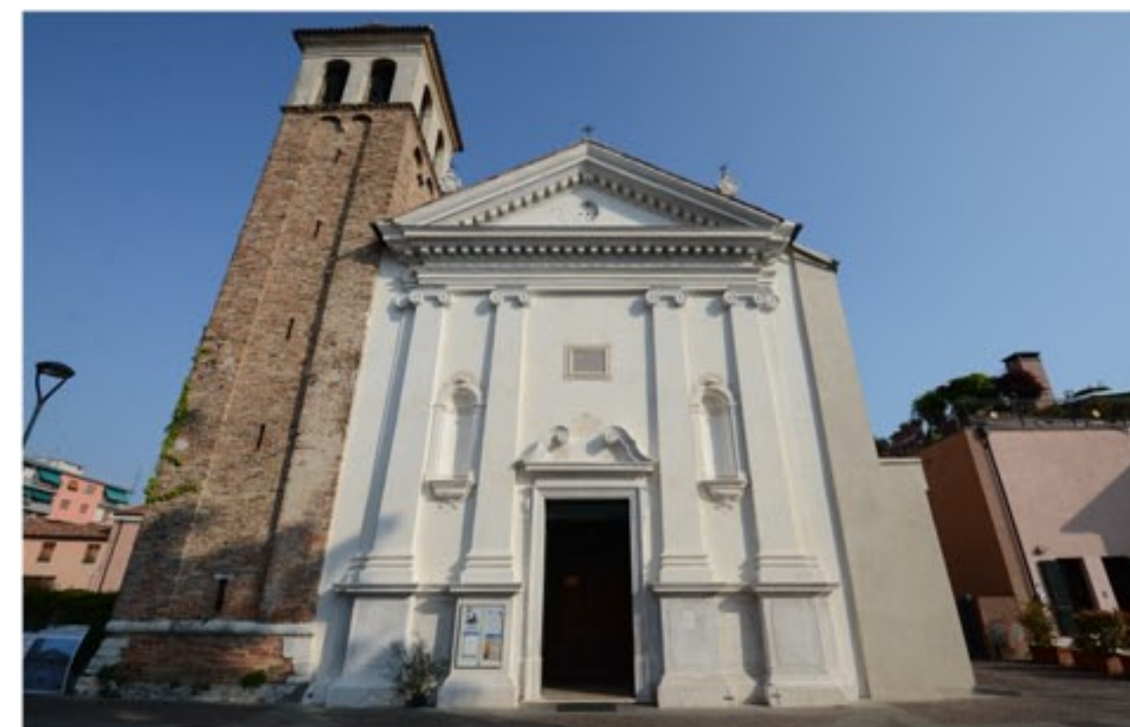
facciata principale a restauro ultimato
