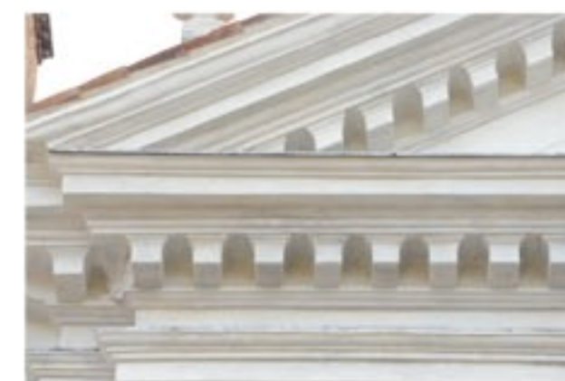
timpano a restauro ultimato
