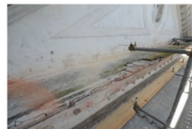
cornicione prima del restauro
